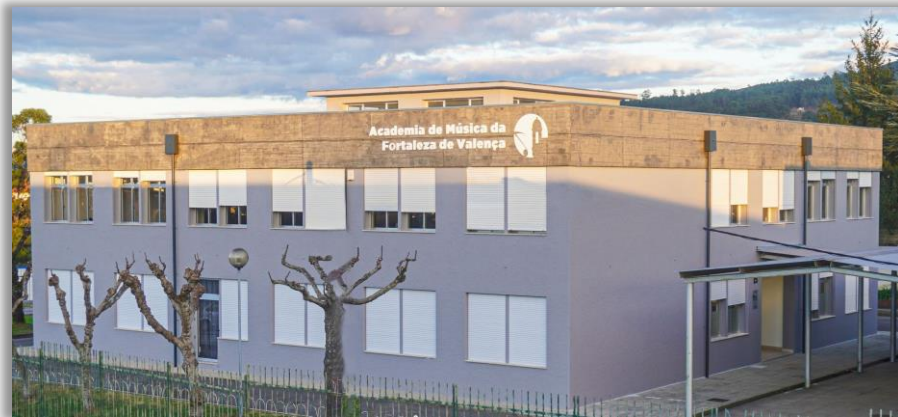
Novas Instalações Zona Escolar, Bloco B Janeiro de 2024
